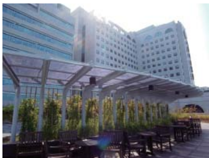
アサンメディカルセンターの屋上庭園
